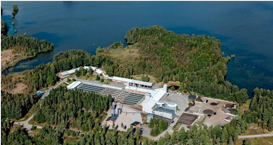
Sundets reningsverk tar emot avloppsvatten från bland annat Växjö. Foto Växjö kommun.
